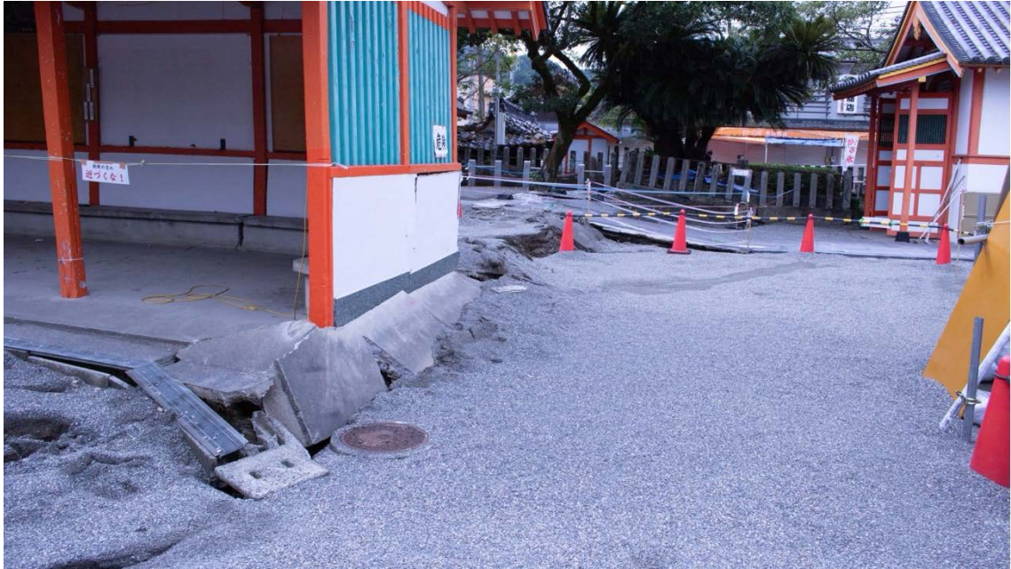
写真 4. 八代神社境内に出現した地表地震断層。地震断層は、写真の左手前から奥に向かって、南南西に連続する（写真は北から南に向かって撮影）。写真の奥の玉垣も地震断層により、右側（西側）が低下している。[岡田真介撮影]
