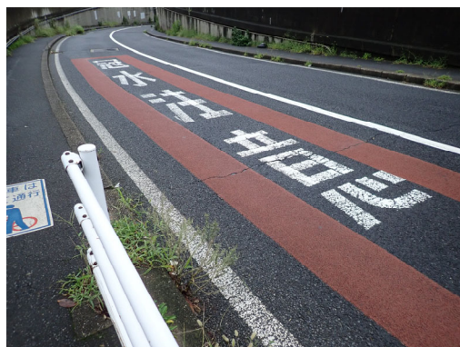
弁天地下道入り口
