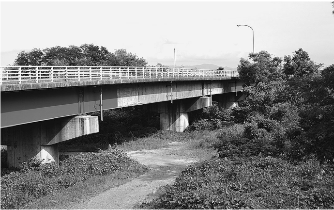
補修が進む胆沢川橋
