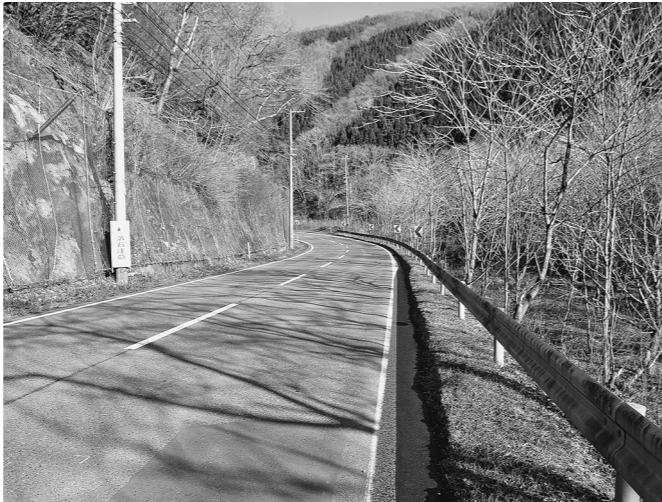
峠区間の国道107号現道
