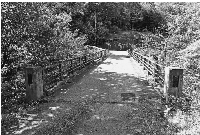
町道早坂1号線の栗宿橋
