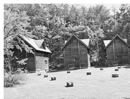
改修を計画するコテージB棟
