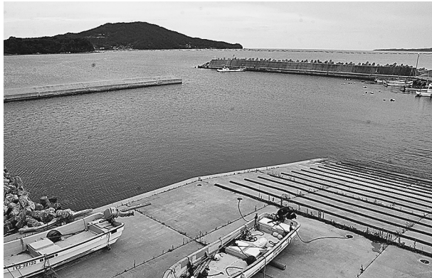
防砂堤などが整備される脇之沢漁港
