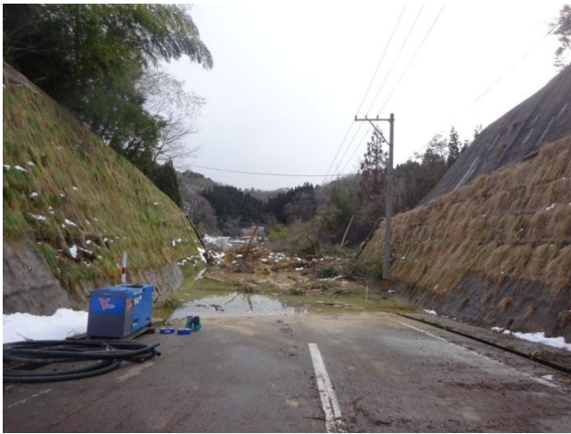
写真3. 地震による土砂災害で寸断された道路
