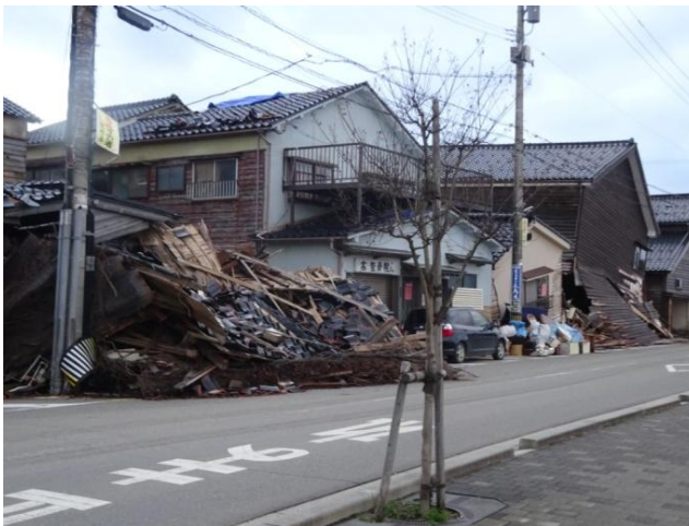
写真5. 地震による木造建築物の倒壊
