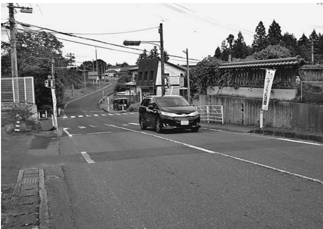
長島地区の改良区間の現道
