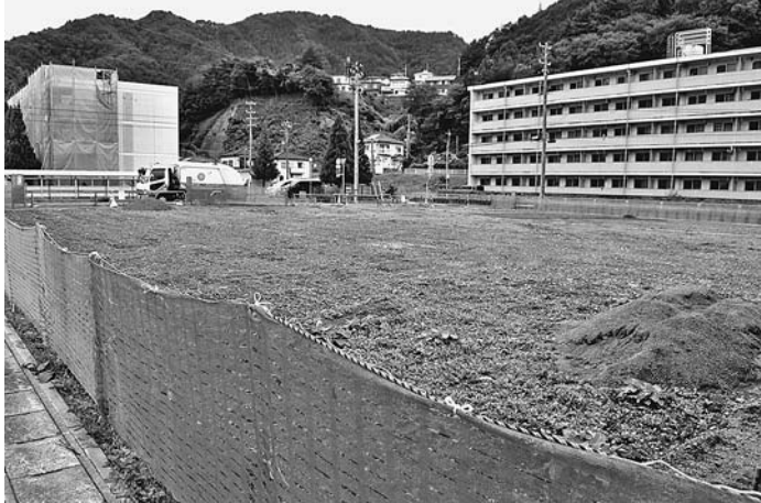
事業所が新設される釜石市内の建設地
