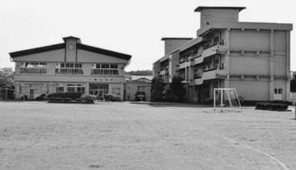
復旧工事を行う一関小
