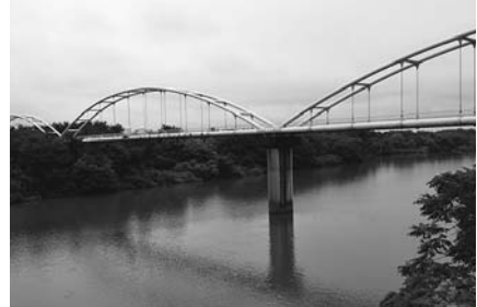
劣化調査を行う和賀川水管橋
