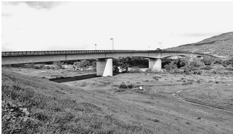
補修を計画する高館橋
