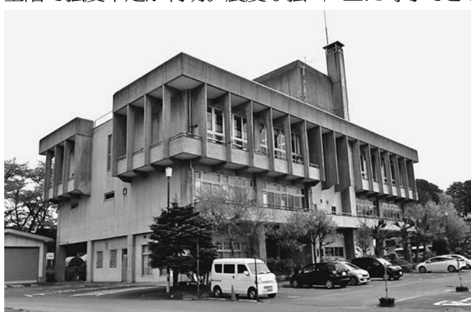
大規模改修が計画されている盛岡市立図書館
