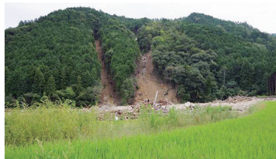
写真-6 野呂川ダム上流域の土砂災害
