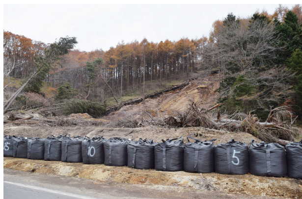
写真2 土砂崩壊箇所
