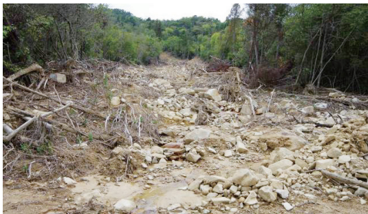
写真-5 広島県広島市黒瀬町の土砂災害
