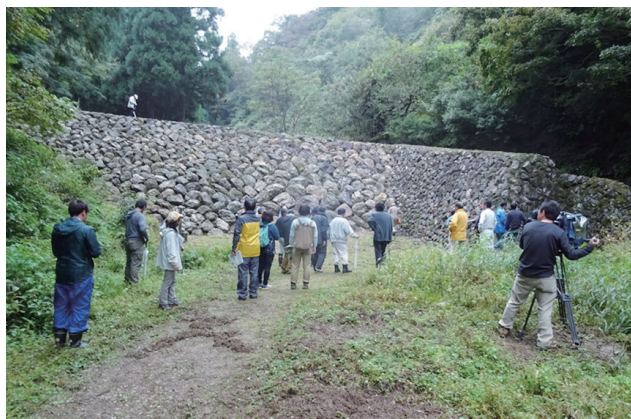
福井県アカタン砂防松ヶ端堰堤
