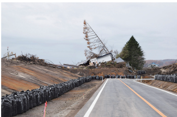
写真1 土砂を取り除いて確保された道路・厚真町吉野地区
