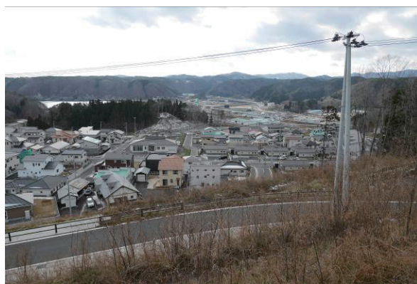
図－1 宮古市田老地区の復興状況 (2017 年 12 月 20 日撮影)
