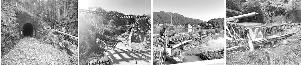
①土砂流入 釜石トンネル (釜石駅～両石駅間)      ②路盤流出 (岩手船越駅～織笠駅間)      ③第1釜石街道踏切付近 (払川駅～津軽石駅間)      ④土砂流入・道床流出 (普代駅～白井海岸駅間)
