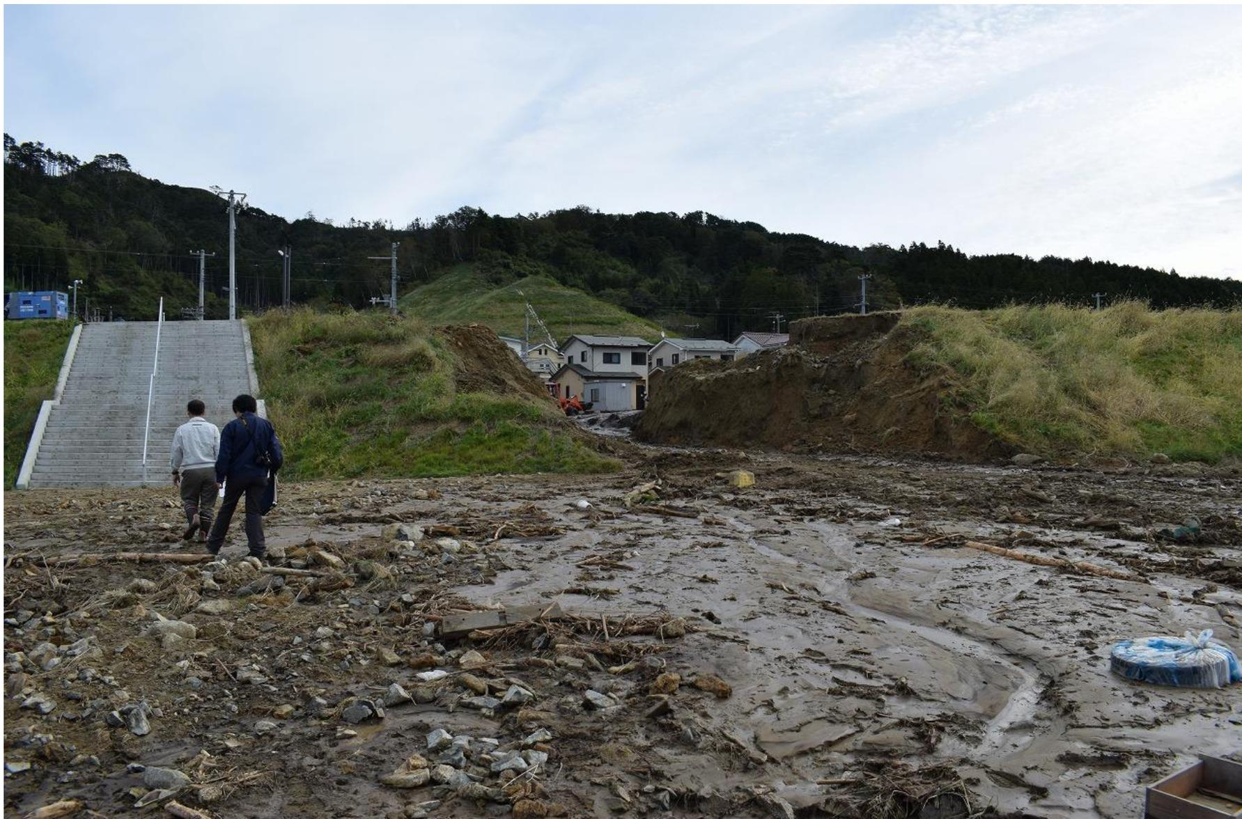
盛土の一部が崩壊し、水の流れた跡
