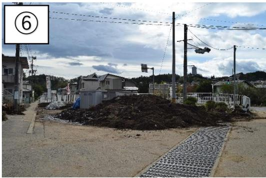
暗渠開始場所のフィルターへの塵芥堆積により、上流部で越流した流れが道路冠水、家屋の浸水につながった。
