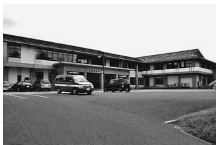
年度内に空調設備を設置完了へ(写真は平泉小)
