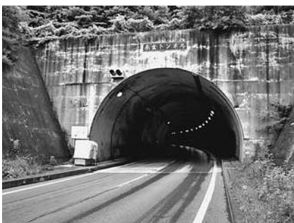
補修を計画する赤金トンネル
