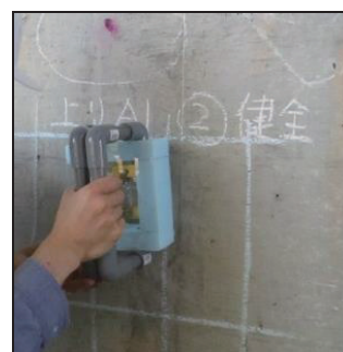
図-2 現場測定の様子
