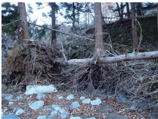
写真-3 河岸侵食によって根が露出したスギ
