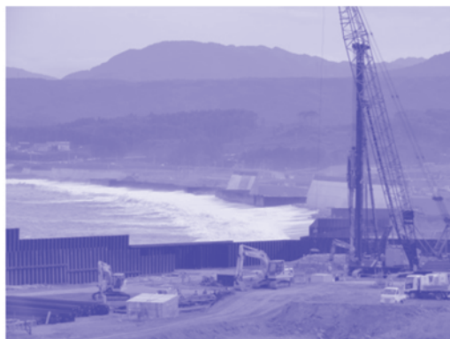
野田海岸防潮堤工事
