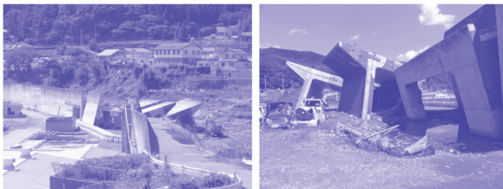
津波により破壊された唐丹湾小白浜漁港の防潮堤
