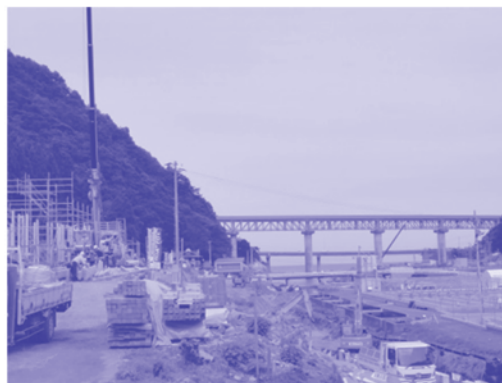
野田村下安家高上げ工事
