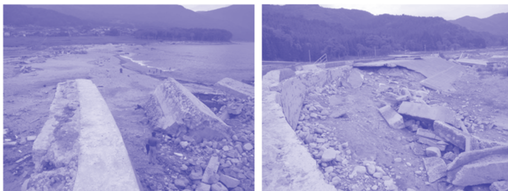
津波により破壊された吉浜湾吉浜農地海岸の防潮堤
