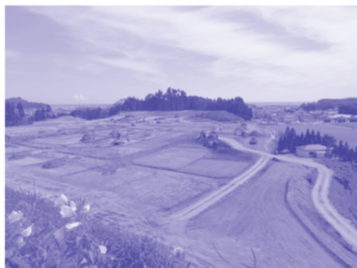
野田村城内高台築造工事
