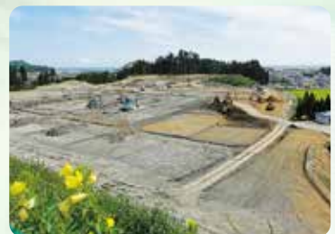
野田村城内高台築造工事の様子
