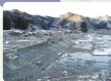
津波により被災した岩泉町小本地区
