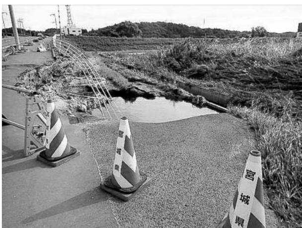
図-3 善川の氾濫箇所近くの道路の被害の様子
