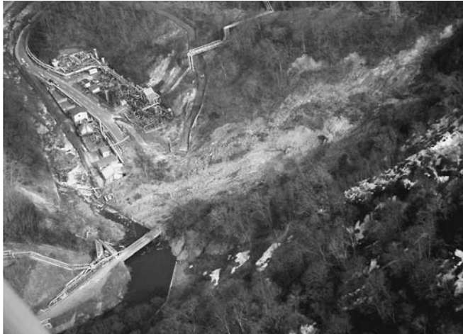
2008年4月20日に岩手県雫石町葛根田で発生した融雪による地すべりと被災した地熱発電所(撮影:井良沢道也)
