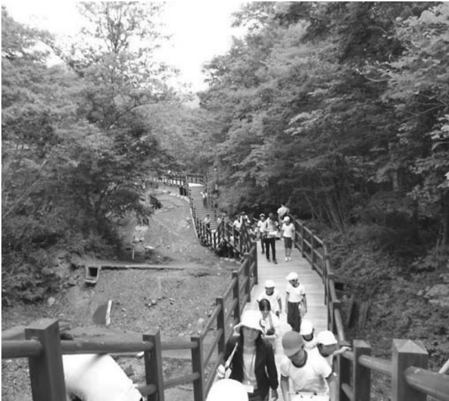
祭時大橋見学通路（地震時の地すべりで道路がうねっている様子が見える）
