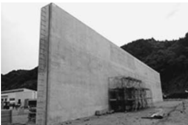
②建設中の新防潮堤（2015年5月12日撮影）
