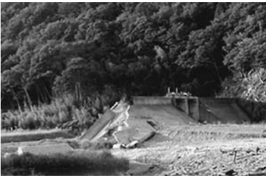
①壊滅的な被害を受けた旧防潮堤左岸側（2012年9月10日撮影）
