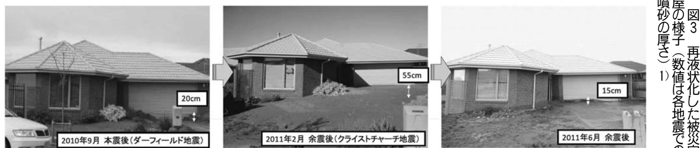
図3 再液状化した被災家の様子
