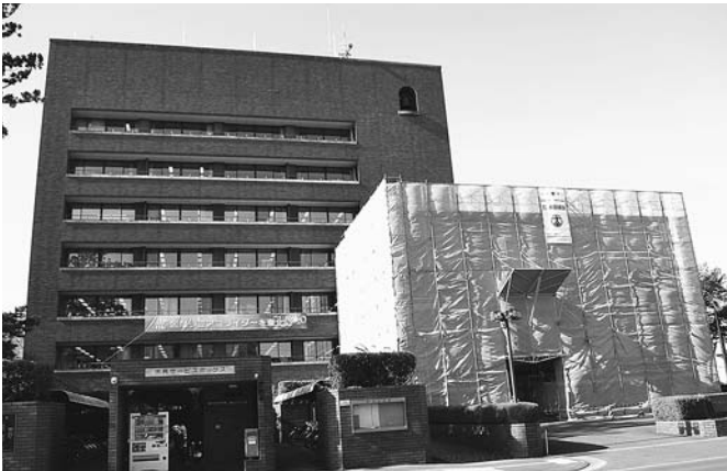
奥州市役所本庁舎
