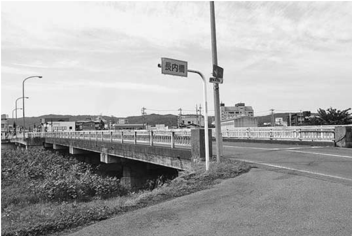
久慈市内に架かる長内橋
