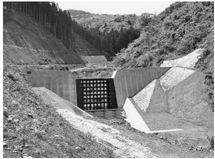
完成した本宿の沢の1基目の堰堤
