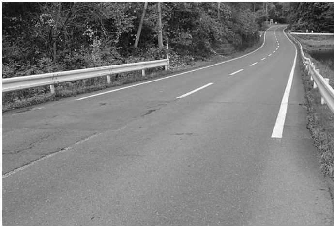
舗装の個別施設計画策定を計画(写真は町道西部開拓線)
