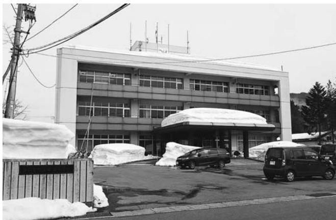
湯田庁舎では耐震補強工事を実施する
