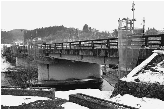
補修工事が進む生出橋
