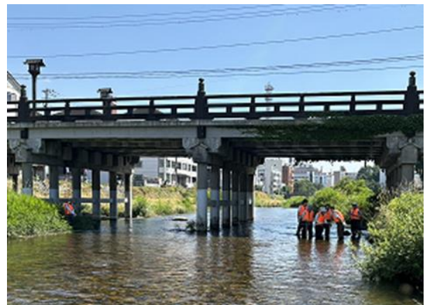
写真－屋外調査
