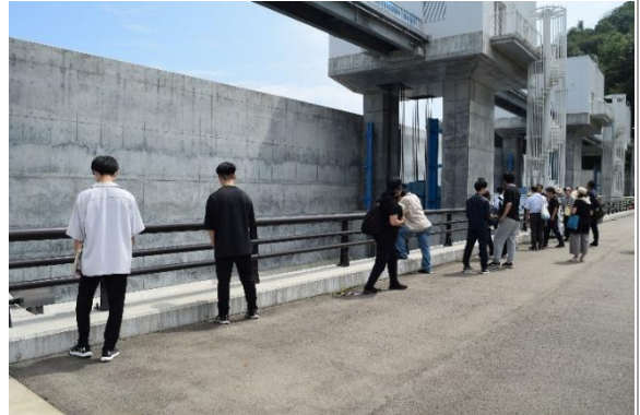
写真一 田代川水門
