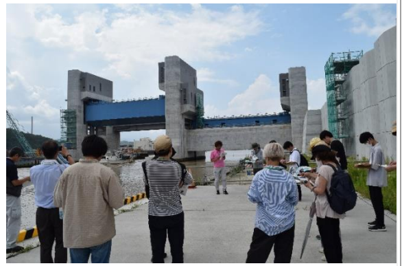
写真一 閉伊川水門
