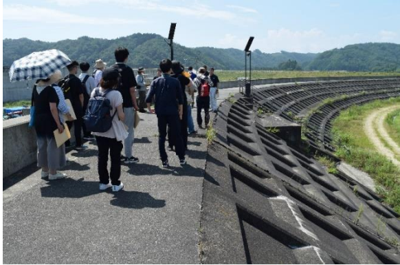
写真一 田老海岸防潮堤
