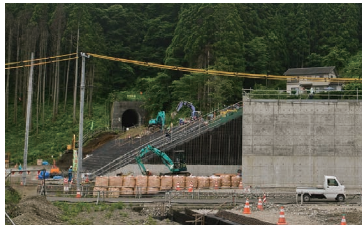
三陸鉄道 島の越付近の復旧工事 (2013年7月22日撮影)
