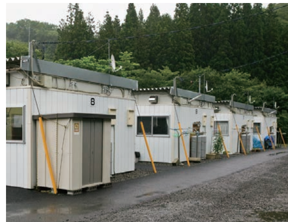
仮設住宅 (山田町 / 2013年7月22日撮影)
