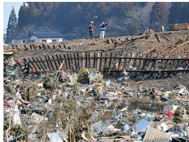
鉄道のレールが流された釜石市鶴住居町：平成 23 年 3 月 13 日撮影(岩手日報社「平成の三陸大津波」より提供)
