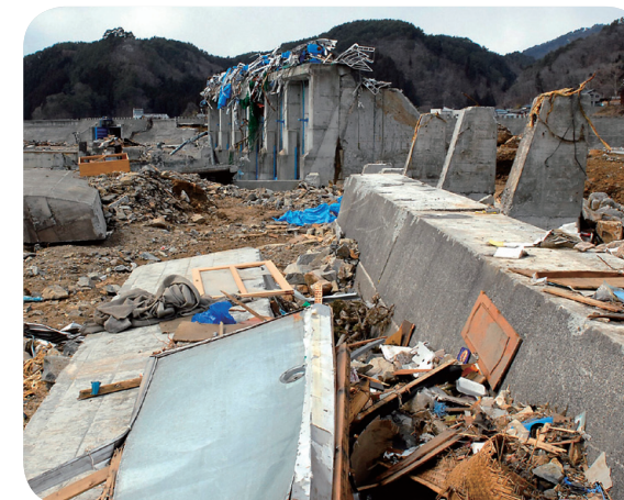
水門だけが残る宮古市田老の防潮堤：平成23年4月2日撮影（岩手日報社「平成の三陸大津波」より提供）
